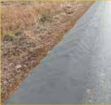
法肩施工写真
