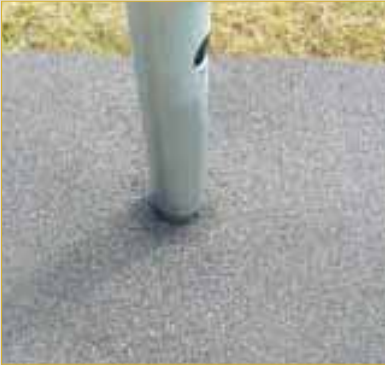
支柱部施工写真
