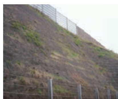
ネット取付完了
