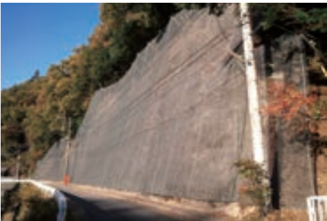
ポケット式落石防護網工との併用例
