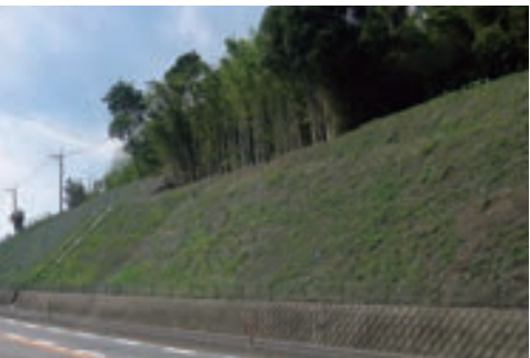
切土斜面への設置例
