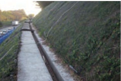
切土斜面への設置例
