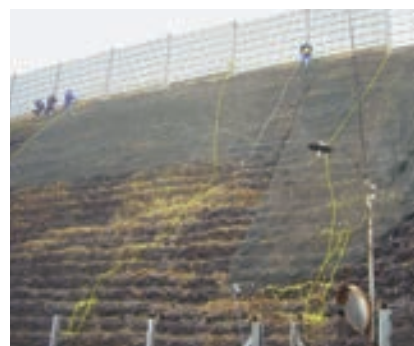
ネット取付状況
