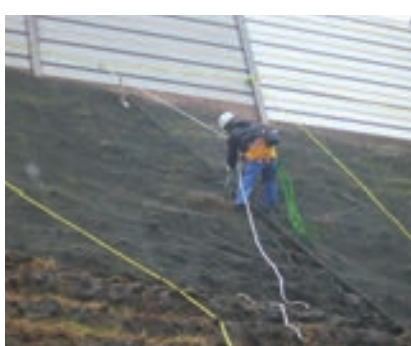
アンカーピン取付状況
