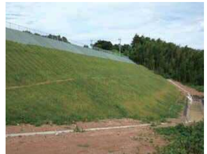
〔施工後〕 3 ヶ月経過
