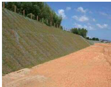
〔施工後〕 1 ヶ月経過
