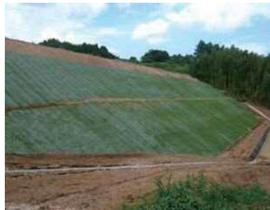
〔施工後〕 1 ヶ月経過 九州北部豪雨直後
