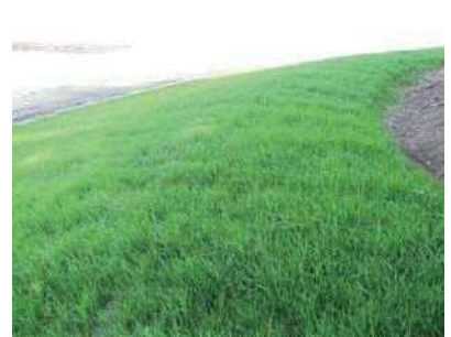
〔施工後〕 3 ヶ月経過
