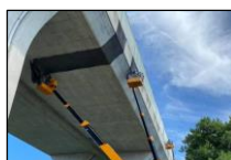
剥落防止ネット 設置工事の様子
